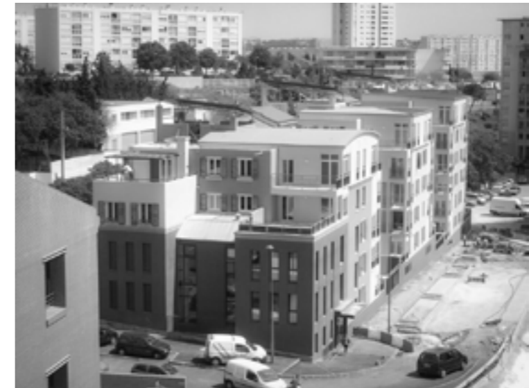
Les Flamants, étape de la rénovation
